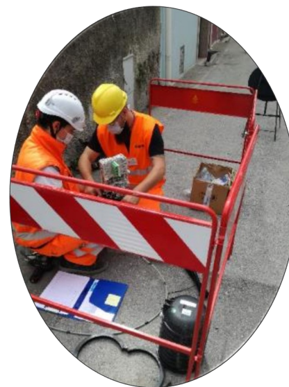
Giunzione del cavo in fibra ottica dalla strada all'abitazione
